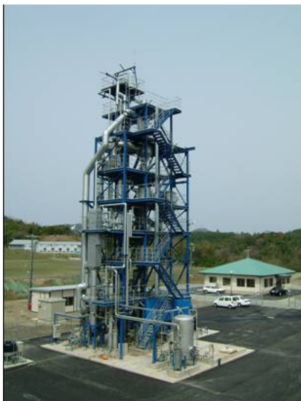
島根県出雲市のブルータワー実証プラント(原料の木質チップ1日1t規模)
