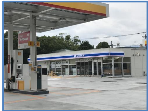
ローソン外観
